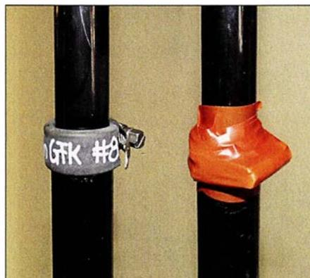
**Bild 39: Montierte Schelle (links), mit Klebeband umwickelt (rechts)**
