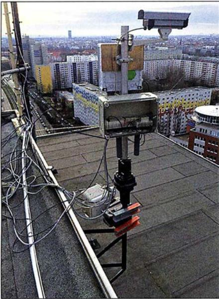
Die Outdoor-Unit von DB0KK: im Vordergrund die 24-GHz-Bake, darüber die 47-GHz-Bake und eine LAN-Kamera (damit DC7YS weiß, in welche Richtung die Bake steht); am Mastfuß ist der Rotor zu sehen.
