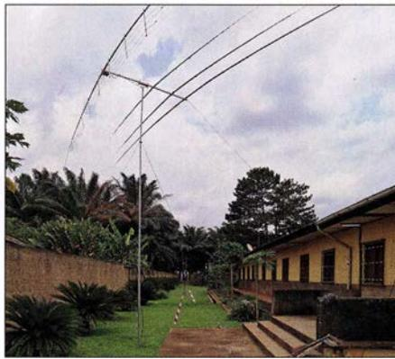
**Zwei-Element-Fünfband-Yagi für die RTTY-Station**
