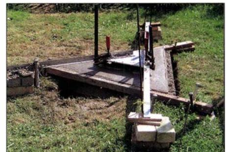
Bild 4: Fundamentguss mit sorgfältig fixierter Unterkonstruktion
